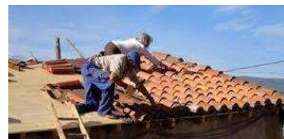
Organizados en grupos de trabajo, los refugiados ya trabajan en la rehabilitación de las viviendas que ocuparán
