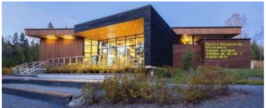
El nuevo Centro Receptor de Visitantes, recientemente inaugurado
